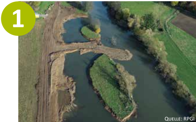
Aufweitung des Gewässerlaufes der Lahn an der Gisselberger Spannweite während der Bauphase
