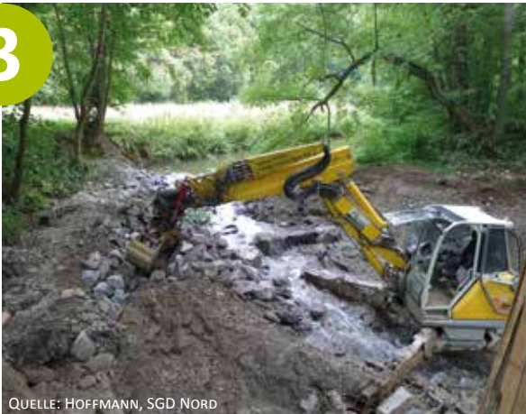
Herstellung der Riegelrampe am Wehr der ehemaligen Langauer Mühle
