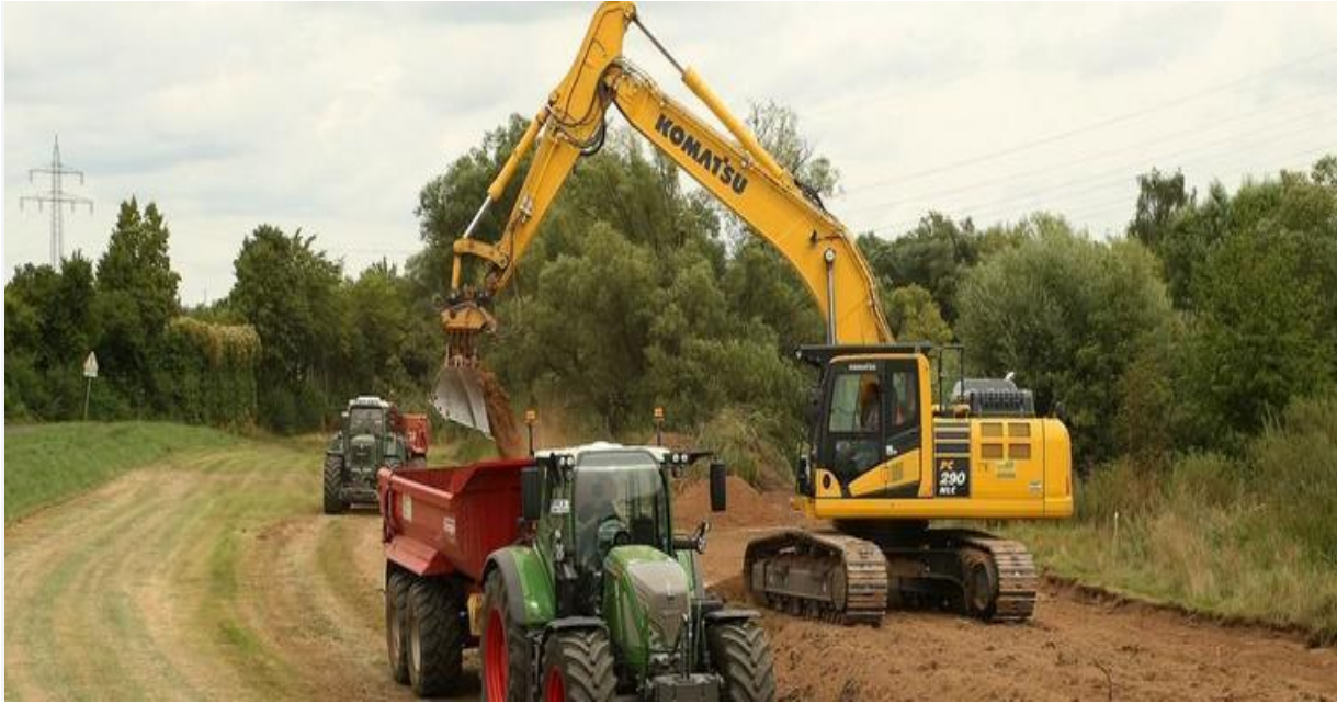
Bauarbeiten an der Lahn während der Renaturierungsarbeiten. Foto: Katja Peters
