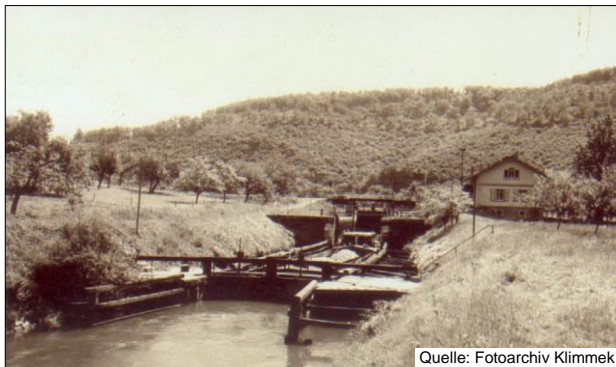
Alte Aufnahme: Schleuse Ahl mit hölzerner Hilfsschleuse (ohne Jahresangabe)
