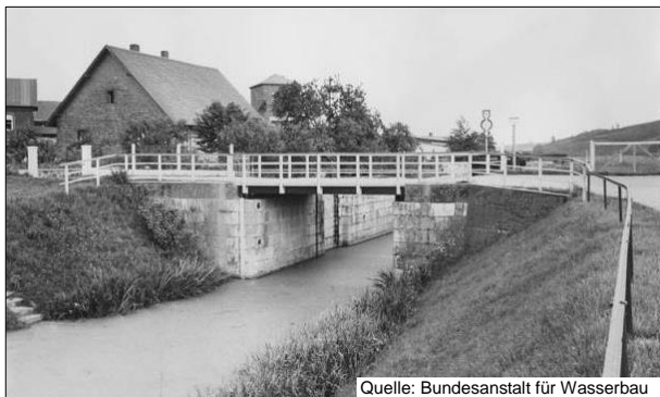
Alte Aufnahme: Schleuse Dorlar (1954)
