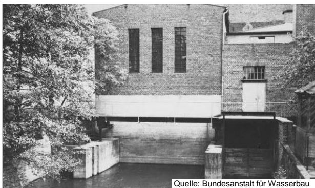
Alte Aufnahme: Wasserkraftanlage Dorlar Neumühle (1961) Lahn km 4,700
