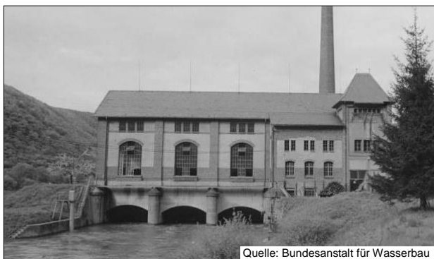
Alte Aufnahme: Wasserkraftanlage Friedrichsseggen (1961)
