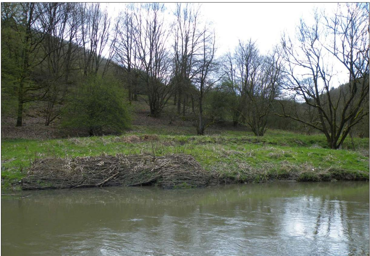
**Abbildung 3-12:** Naturnahe Ufersicherung mit Weidenmatten an der Lahn (Quelle: Teusch, WSA Koblenz)
