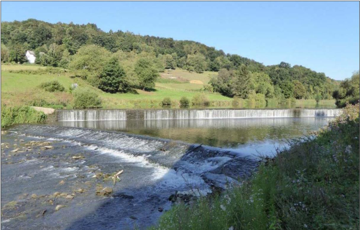
Abbildung 2-3: An der Staustufe Fürfurt bilden Überfallwehr und Streichwehr eine bauliche Einheit (Quelle: Kleinz, WSA Koblenz)
