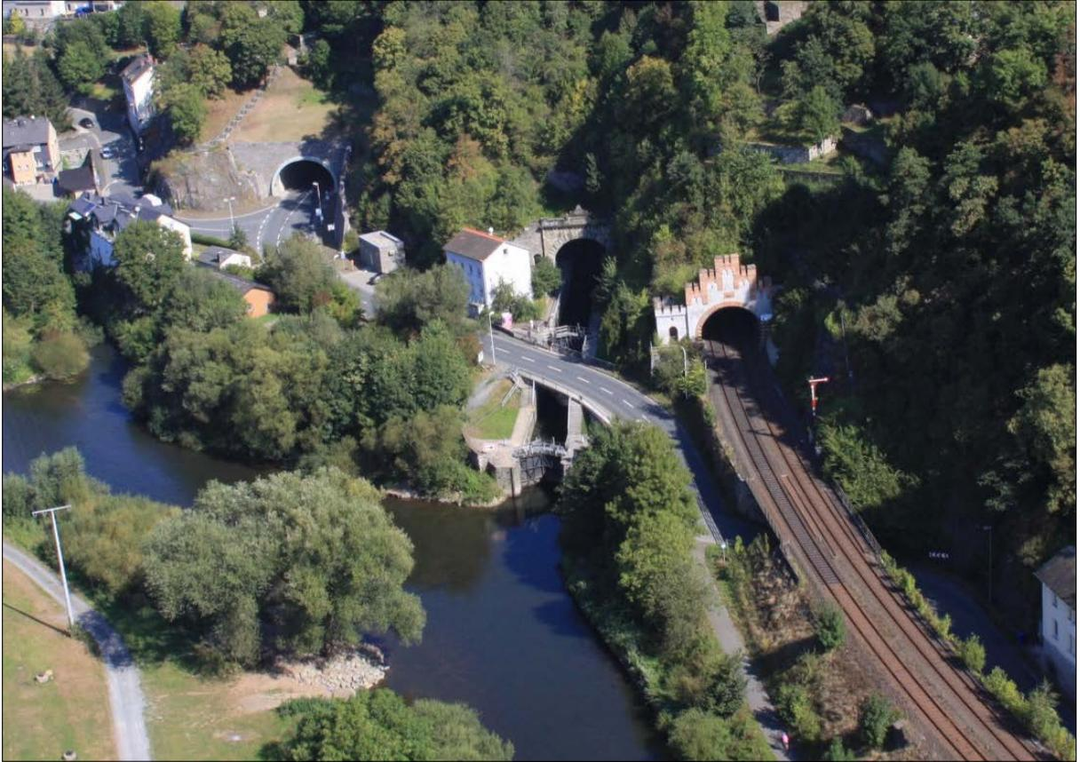
**Abbildung 2-9:** Koppelschleuse und Schiffahrtstunnel Weilburg (Quelle: WSA Koblenz)
