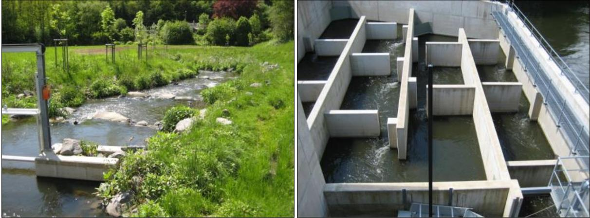
**Abbildung 2-15:** FAA Nassau mit Umgehungsgerinne (links) und angegliedertem Vertical-Slot-Pass (Quelle: WSA Koblenz)
