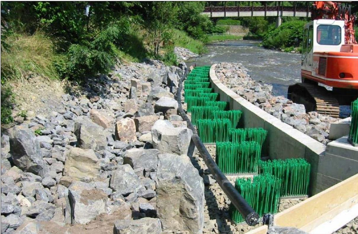
**Abbildung 2-18:** Fisch-Kanu-Pass bei der Münderschen Mühle an der Fulda in Hannoversch Münden [32]
