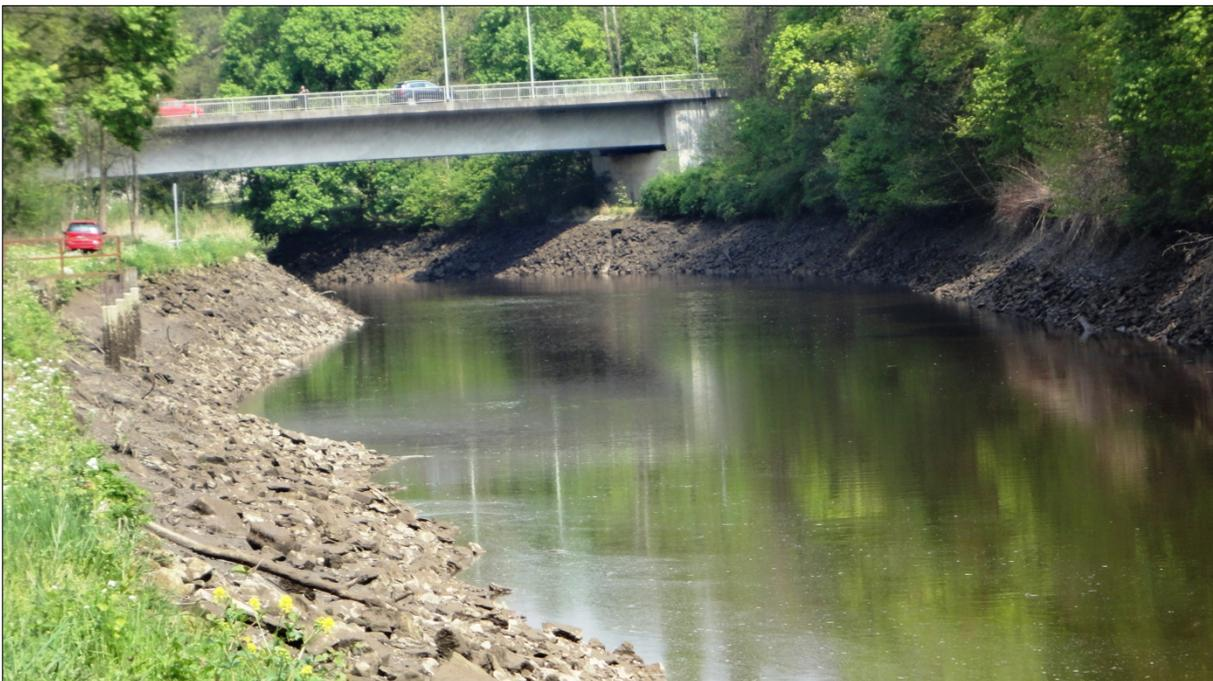
**Abbildung 2-29:** Freiliegende Uferbefestigung (Steinschüttung) nahe Staffel während einer planmäßigen Stauabsenkung (Quelle: WSA Koblenz)
