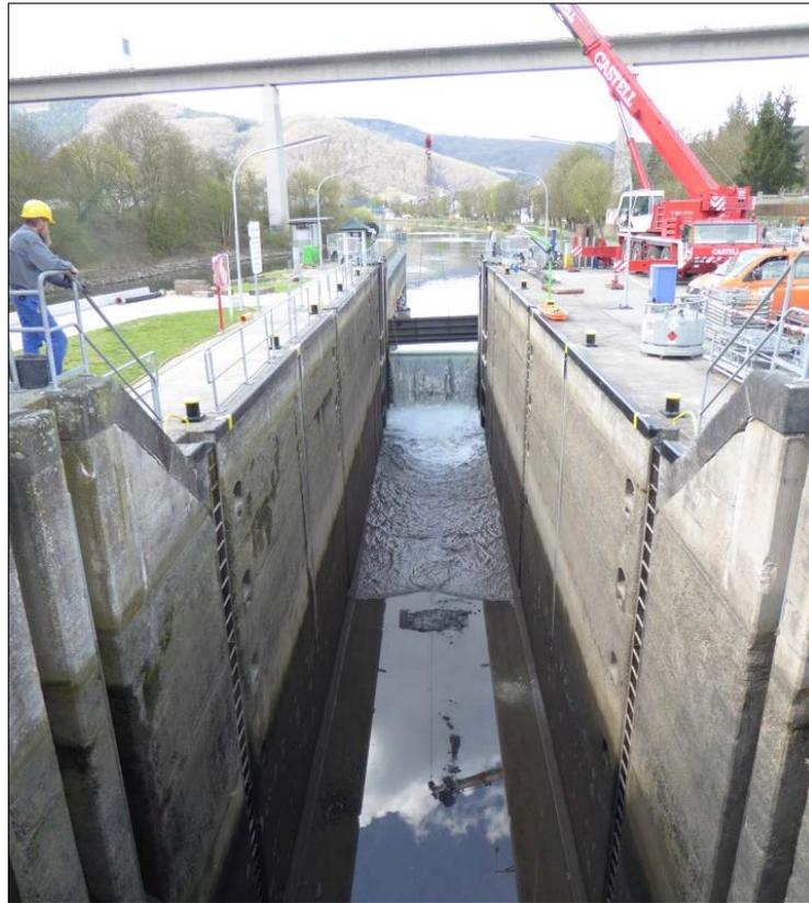
**Abbildung 2-7:** Befüllung der trockengelegten Schleusenammer Lahnstein von Unterwasser (Quelle: Schulze, WSA Koblenz)
