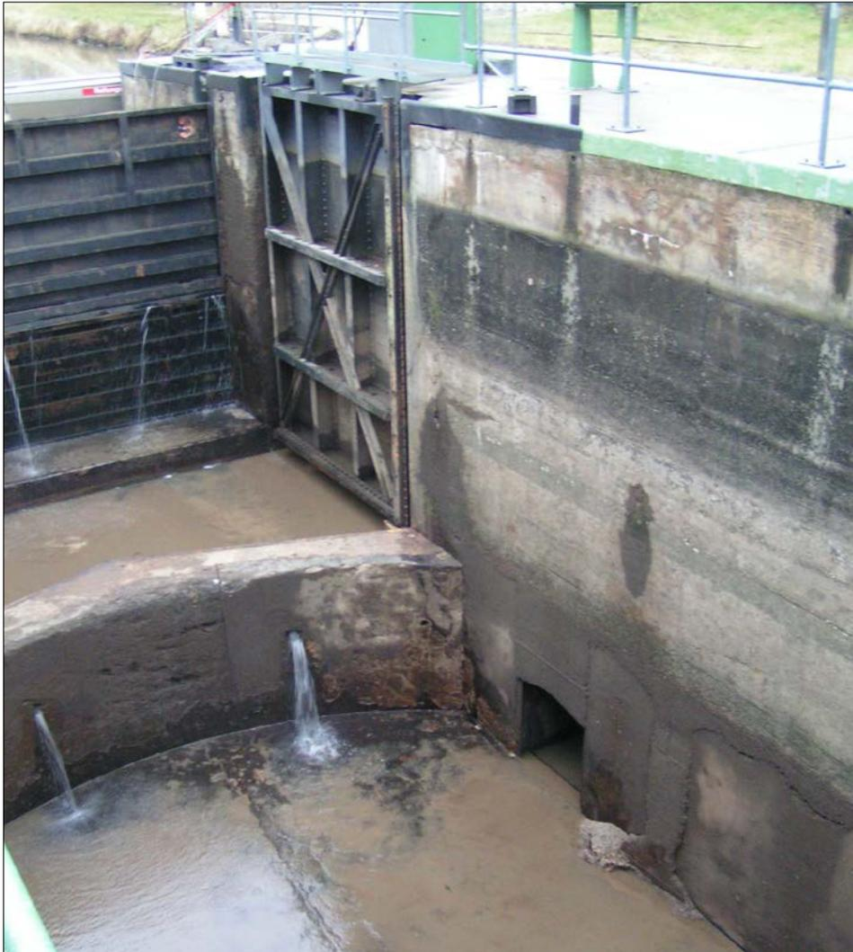
**Abbildung 2-6:** Oberhaupt der Schleuse Diez (Quelle: WSA Koblenz)
