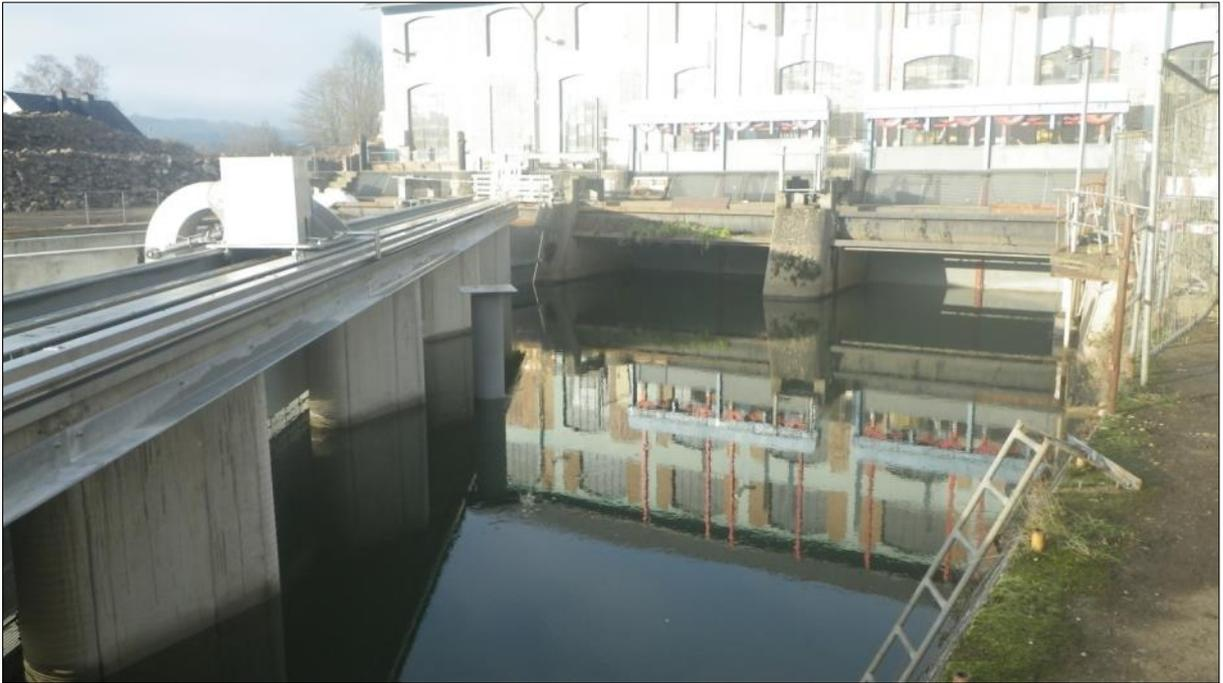
**Abbildung 2-13:** Blick von Oberwasser auf die WKA Oberbiel und den schräg angeströmten Horizontalrechen am linken Bildrand (Quelle: Schulze, WSA Koblenz)
