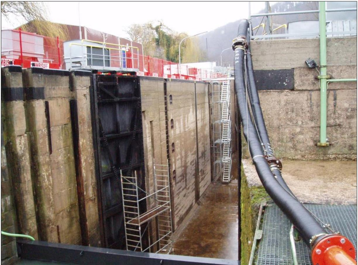
**Abbildung 3-1:** Bauwerksinspektion und Reparaturarbeiten an der Schleuse Lahnstein mit Blick nach Oberwasser (Quelle: WSA Koblenz)
