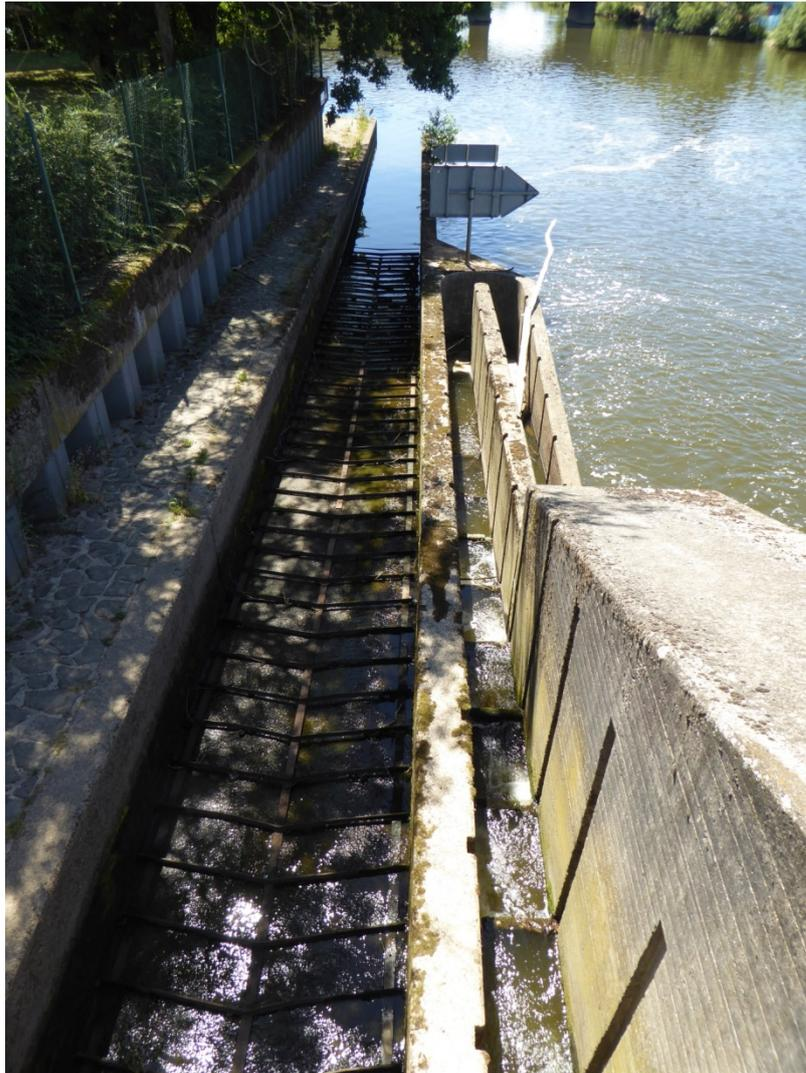
**Abbildung 2-24:** Trockenliegende Bootsgasse am Oberwehr Gießen
