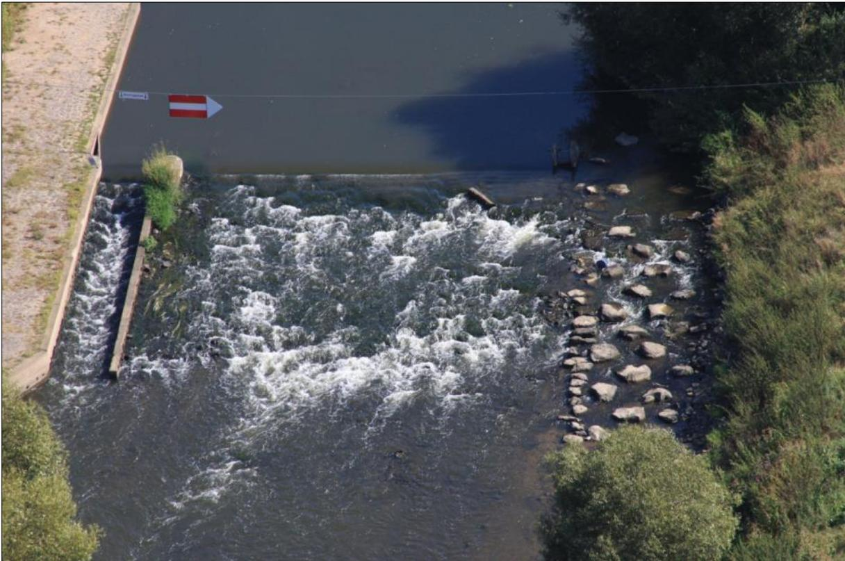
**Abbildung 2-23:** Sohlschwelle Heuchelheim mit Bootsgasse (Quelle: WSA Koblenz)
