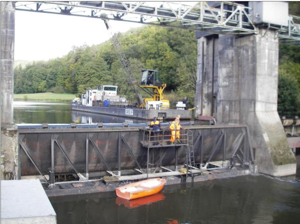
**Abbildung 3-2:** Revision an einem beweglichen Wehr an der unteren Lahn (Quelle: WSA Koblenz)
