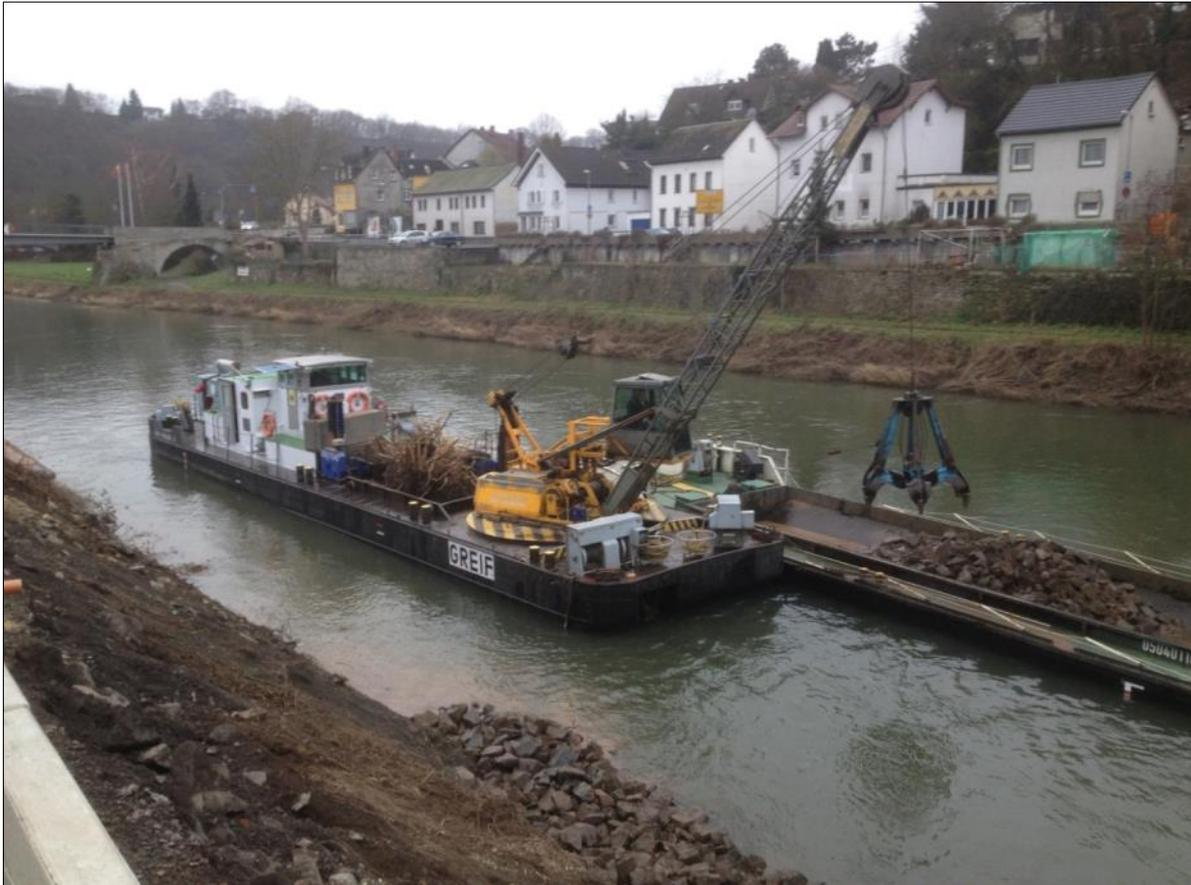
**Abbildung 3-10:** Böschungsarbeiten mit dem Schwimmgreifer „Greif“ (Quelle: WSA Koblenz)
