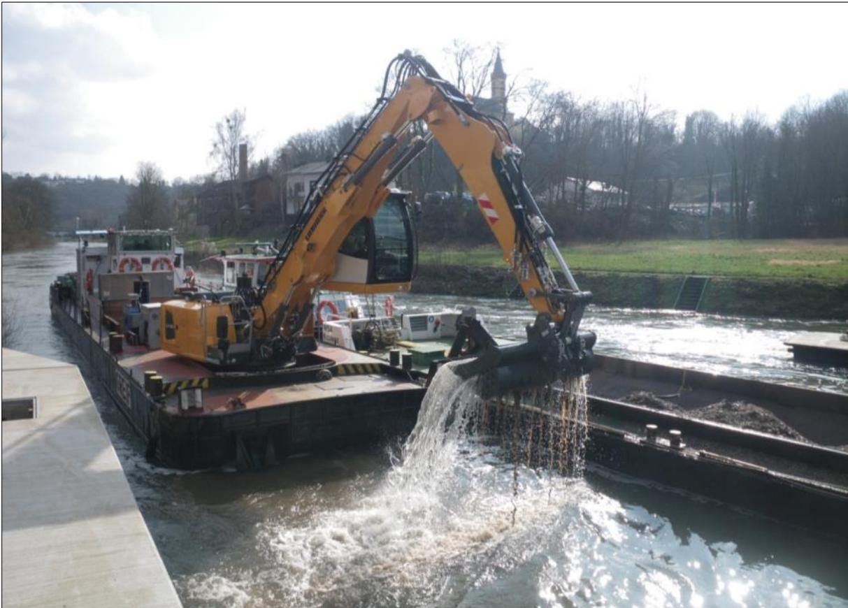
**Abbildung 3-5:** Nassbaggerung im Unterwasser der Staustufe Diez mit dem Schwimmgreifer „Greif“ (Quelle: WSA Koblenz)
