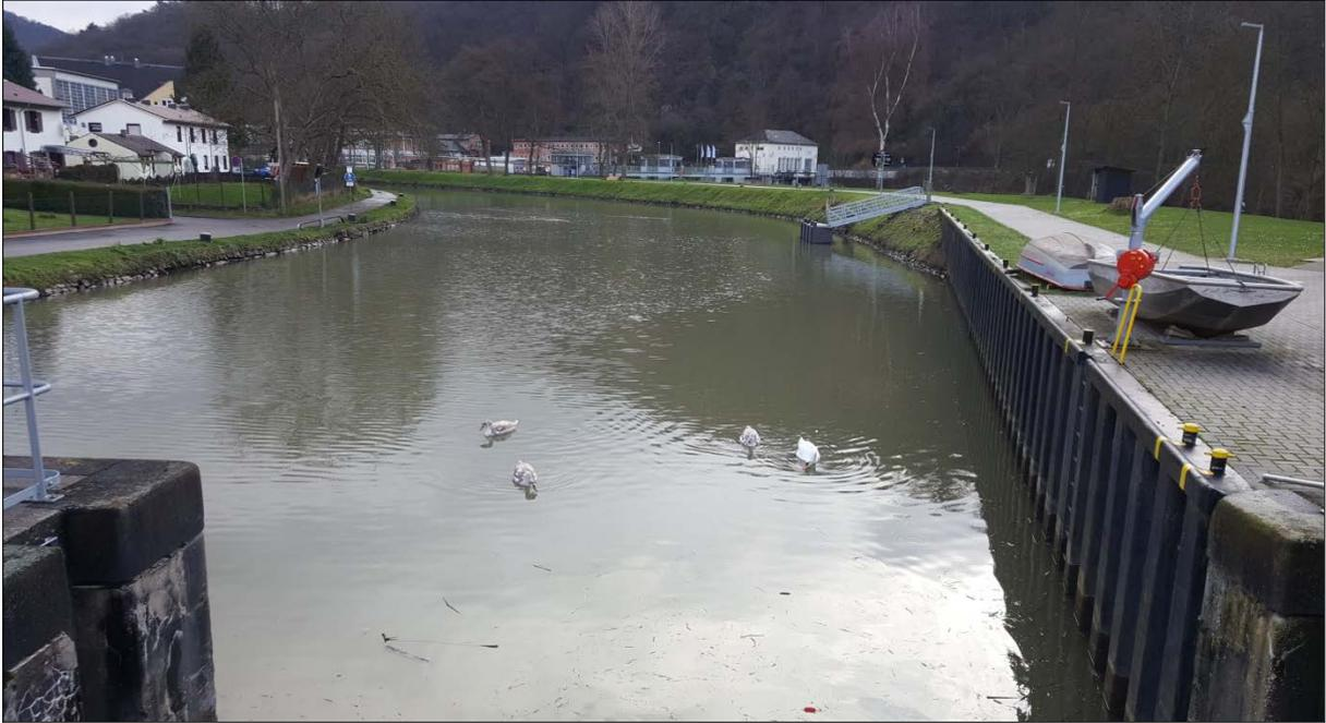
**Abbildung 2-30:** Uferbefestigung mit beidseitigem Pflasterdeckwerk und Spundwand im Oberwasser der Schleuse Lahnstein (Quelle: Schulze, WSA Koblenz)
