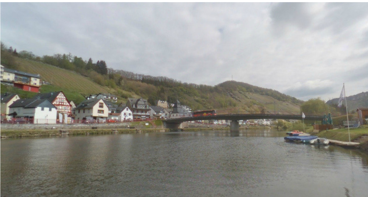
Abbildung 7-5: Lahn bei Obernhof, Blick in Richtung Oberwasser, Quelle: WSA Koblenz, River View
