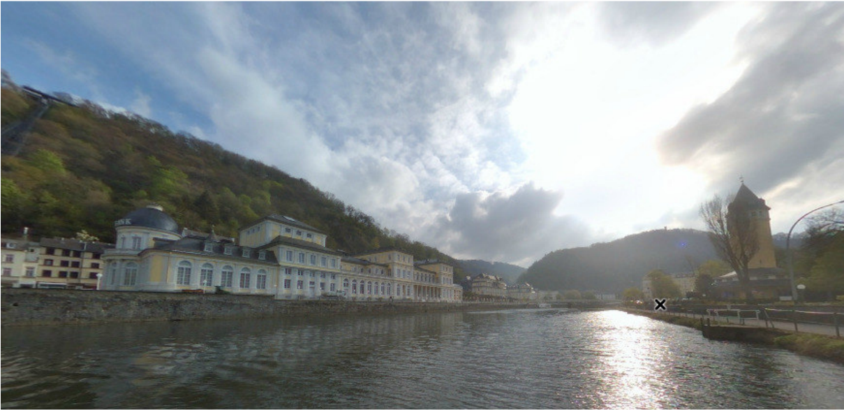
Abbildung 4-4: Blick in Richtung Unterwasser auf Kurhaus und Spielbank Bad Ems, Quelle: WSA Koblenz, River View
