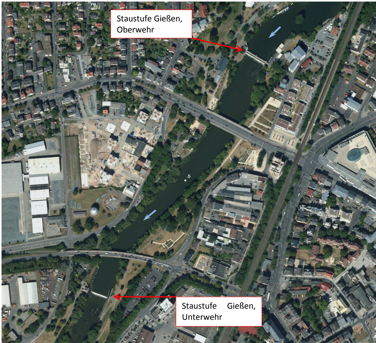
Abbildung 28-1: Luftbild Staustufe Gießen, Unterwehr gesamt, Quelle Luftbilder: Bundesamt für Kartographie und Geodäsie
