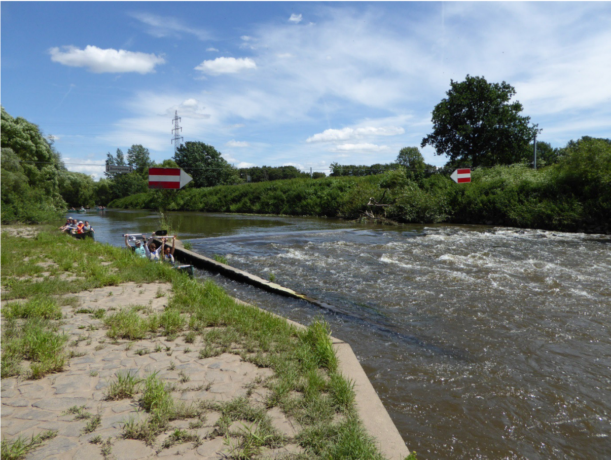
Abbildung 27-5: Sohlschwelle Heuchelheim, Quelle: WSA Koblenz
