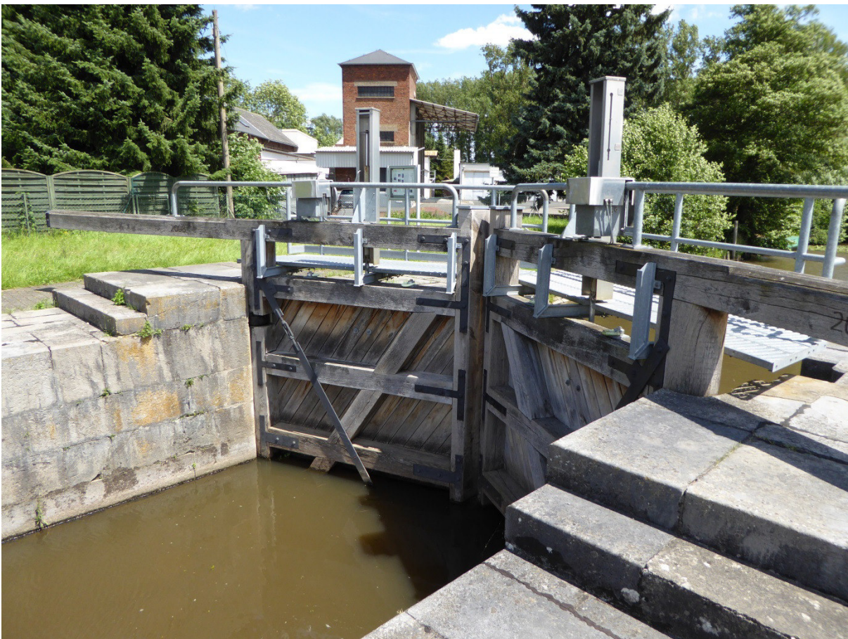
Abbildung 26-4: Obertor Schleuse Dorlar, Quelle: WSA Koblenz
