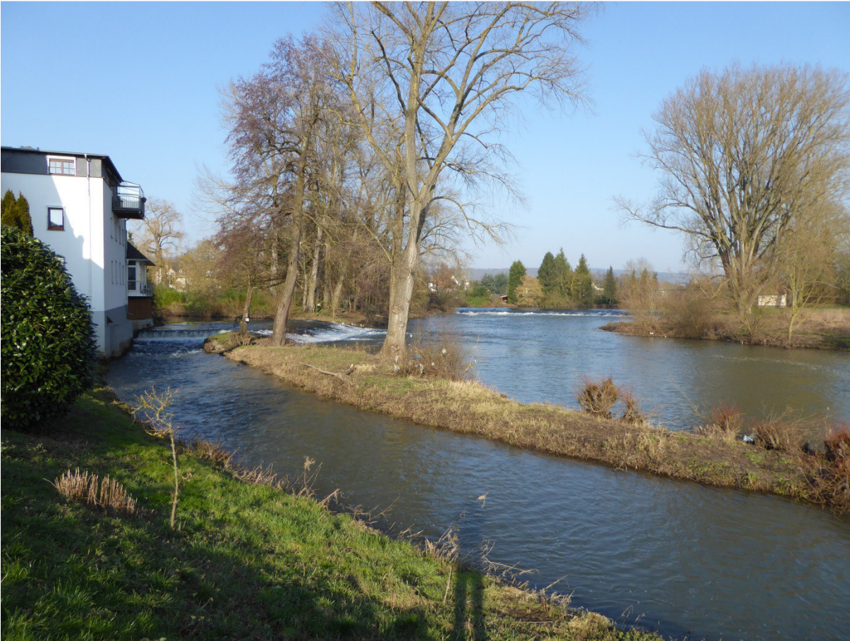
Abbildung 25-4: Blick auf das Wehr in Richtung Oberwasser, Quelle: WSA Koblenz
