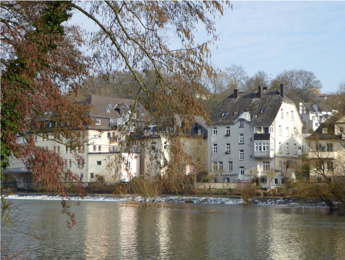
Abbildung 24-4: Blick über das Oberwehr Wetzlar auf die unmittelbar oberhalb gelegene Bebauung, Quelle: WSA Koblenz
