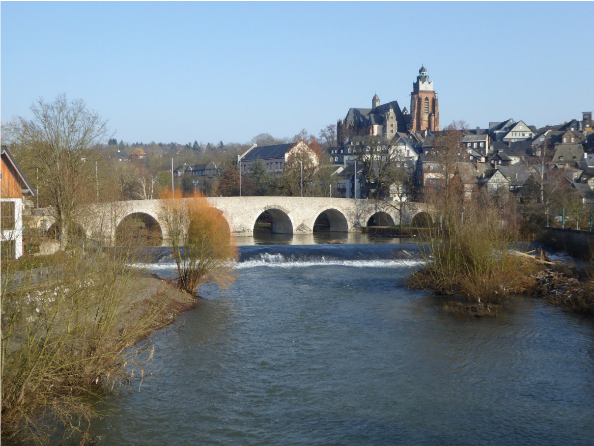
Abbildung 23-4: Unterwehr Wetzlar vor der historischen Bogenbrücke und der Altstadt, Quelle: WSA Koblenz
