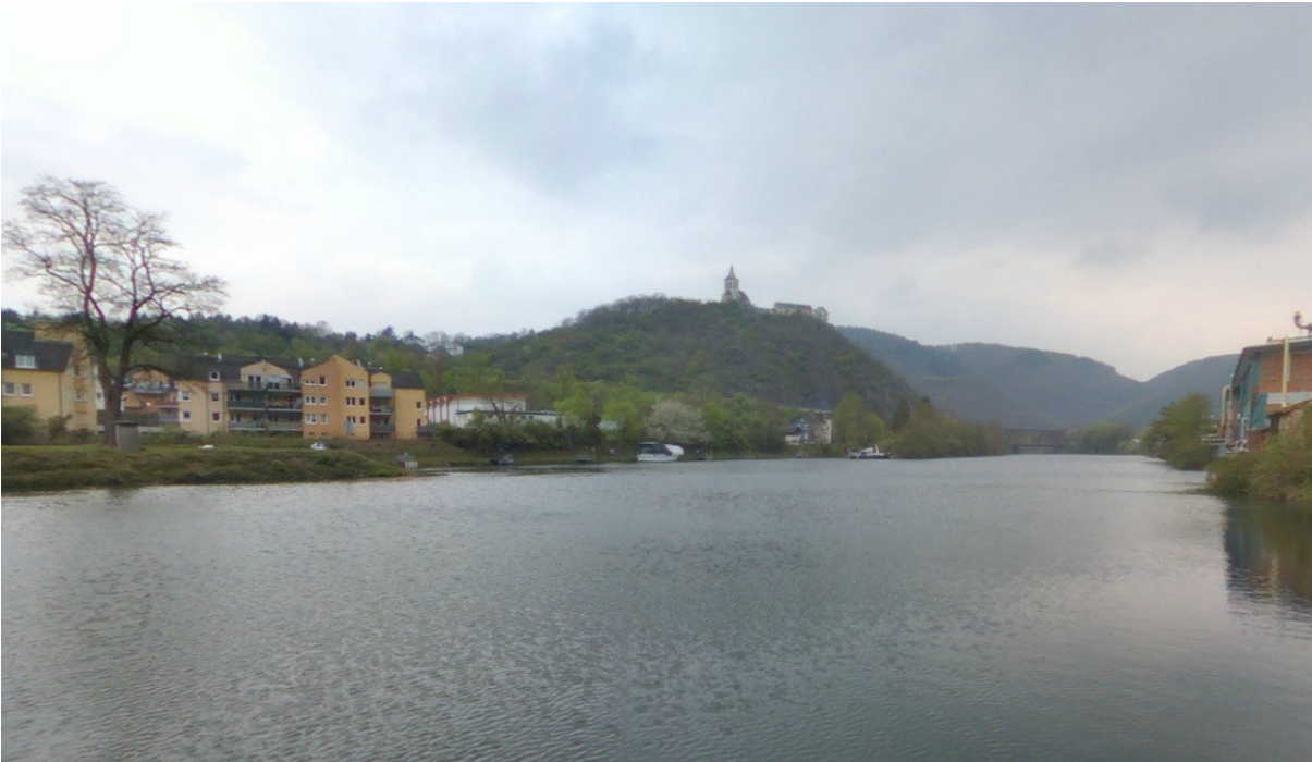
Abbildung 1-4: Blick vom Wehr in Richtung Oberwasser, Quelle: WSA Koblenz, River View
