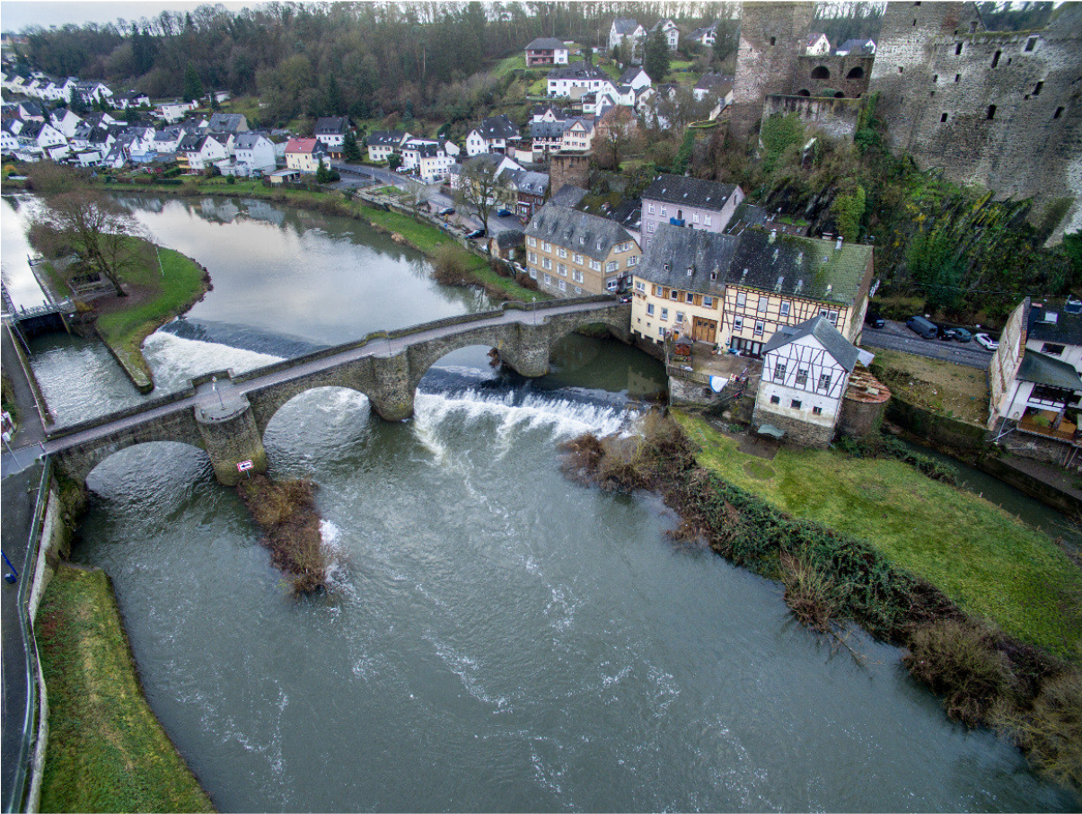
Abbildung 14-4: Blick auf das Wehr und die Schleuse Runkel, Quelle: Regierungspräsidium Gießen
