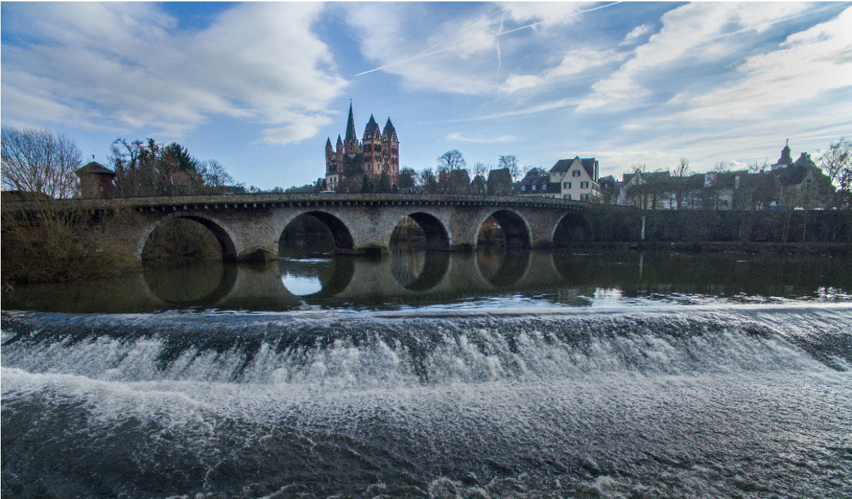
Abbildung 12-4: Blick über das Wehr in Richtung Oberwasser, Quelle: Regierungspräsidium Gießen
