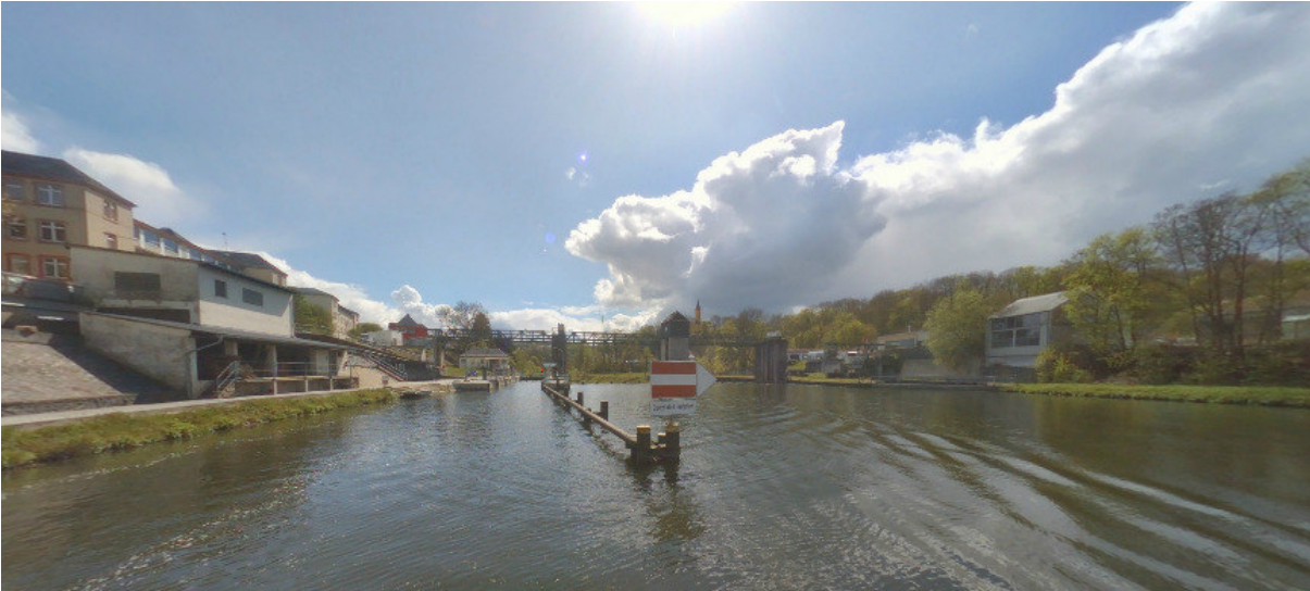
Abbildung 11-4: Oberwasser Schleuse Diez, Blick in Richtung Unterwasser, Quelle: WSA Koblenz, River View
