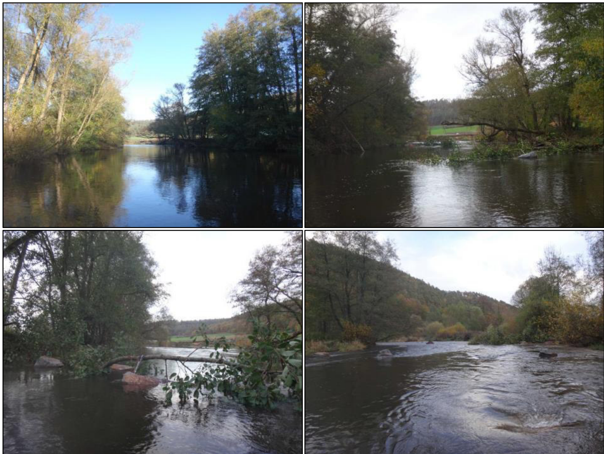
Abb. 27: Strukturierungsmaßnahmen Cölber Furkation. Oben links: Abschnitt vor Einbau Bäume. Oben rechts: Abschnitt nach Einbau Bäume. Unten links: Baum mit Ankersteinen. Unten rechts: Vielfältige Strömungsmuster nach Einbau von Steinen.
