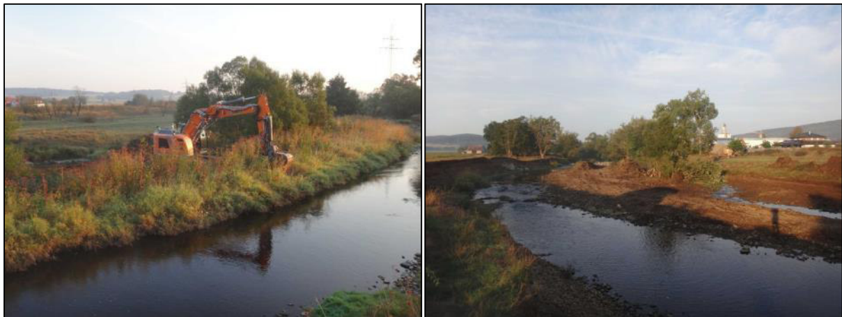
Abb. 23: Strukturierungsmaßnahmen Sterzhausen (1). Links: Kiesbank an Steilwand mit Bewuchs. Rechts: Große Mengen Erde und Feinsedimente auf der Kiesbank.
