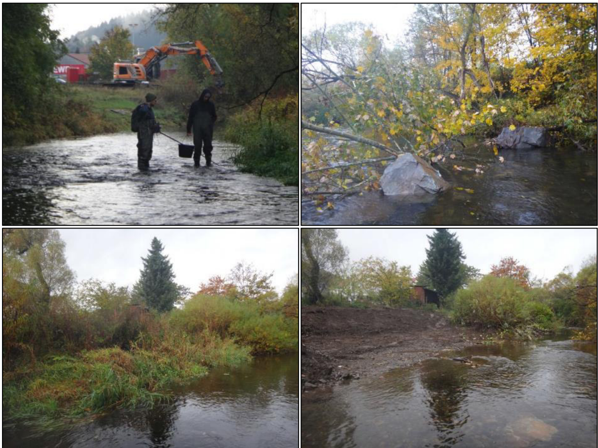
Abb. 19: Strukturierungsmaßnahmen Sachsenhausen (1). Oben links: Bauabfischung für Umsetzung der Maßnahme. Oben rechts: Eingebauter Baum mit Ankersteinen als Strömunglenker zur Kiesbank. Unten links: Kiesbank mit Bewuchs. Unten rechts: Kiesbank nach Schälung.
