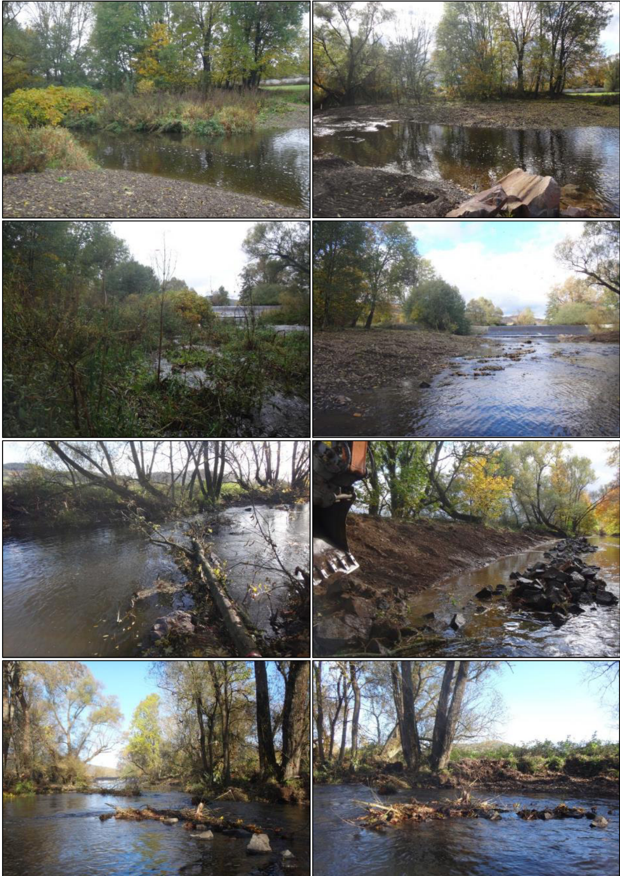
Abb. 21: Strukturierungsmaßnahmen Wilhelmshütte. Oben: Kiesbank vor und nach der Schälung. 2. Reihe: Kiesbank vor und nach Abflachung der Uferzone. 3. Reihe links: Eingebauter Baum als Deckungsstruktur. 3. Reihe rechts: Rückbau der Ufersicherung. Unten: Auf der Gewässersohle verteilte Wasserbausteine.
