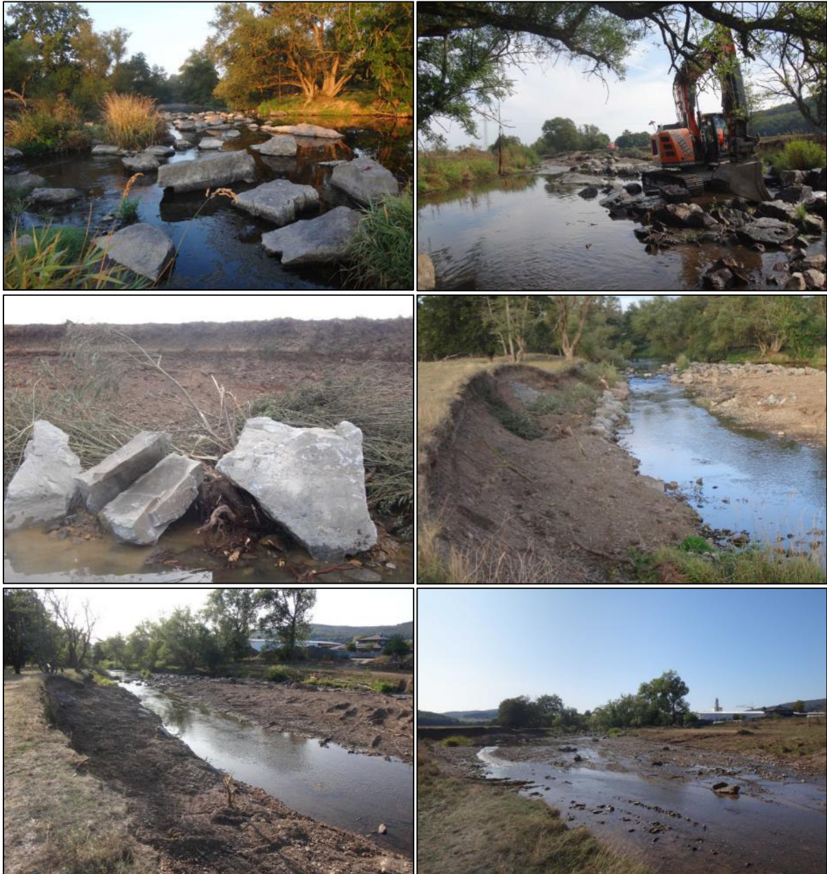
Abb. 24: Strukturierungsmaßnahmen Sterzhausen (2). Oben links: Durch Wasserbausteine verblockte Rinne auf linker Uferseite. Oben rechts: Beseitigung der WBS für verbesserten Durchfluss. Mitte links: Ufersicherung mit Weiden. Mitte rechts: Weiden und Steine werden mit Kies überdeckt. Unten links: Fertige Ufersicherung in Form einer Berme. Unten rechts: Flach überströmte Kiesfläche mit Störsteinen zur Initiierung einer neuen Kiesbank.
