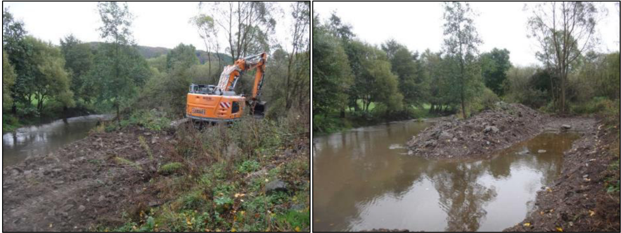
Abb. 18: Strukturierungsmaßnahmen Wallau (3). Anschluss des unteren Nebengerinnes an den Hauptverlauf der Lahn.
