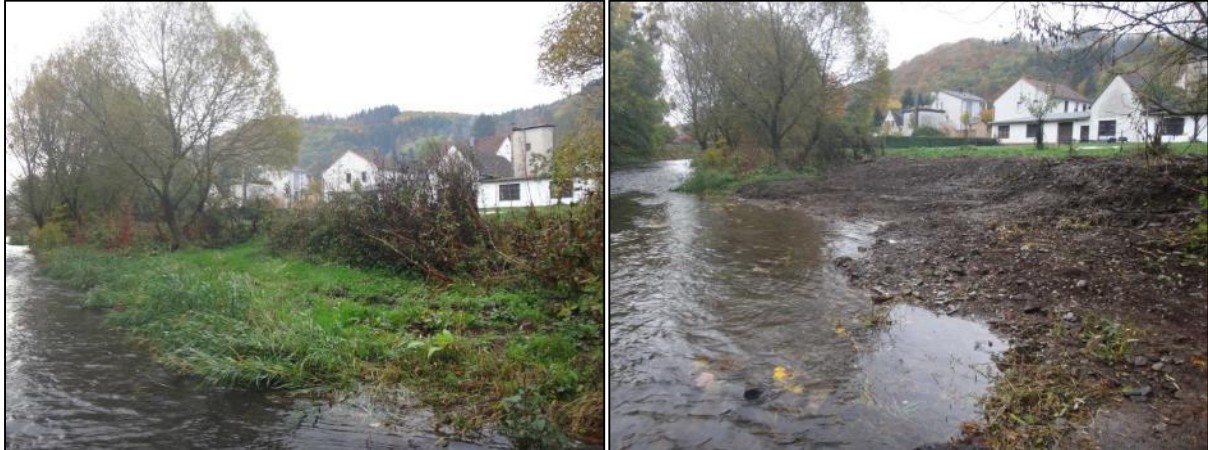
Abb. 20: Strukturierungsmaßnahmen Sachsenhausen (2). Links: Rechte Uferseite mit Bewuchs. Rechts: Rechte Uferseite abgeflacht und mit Buchten.
