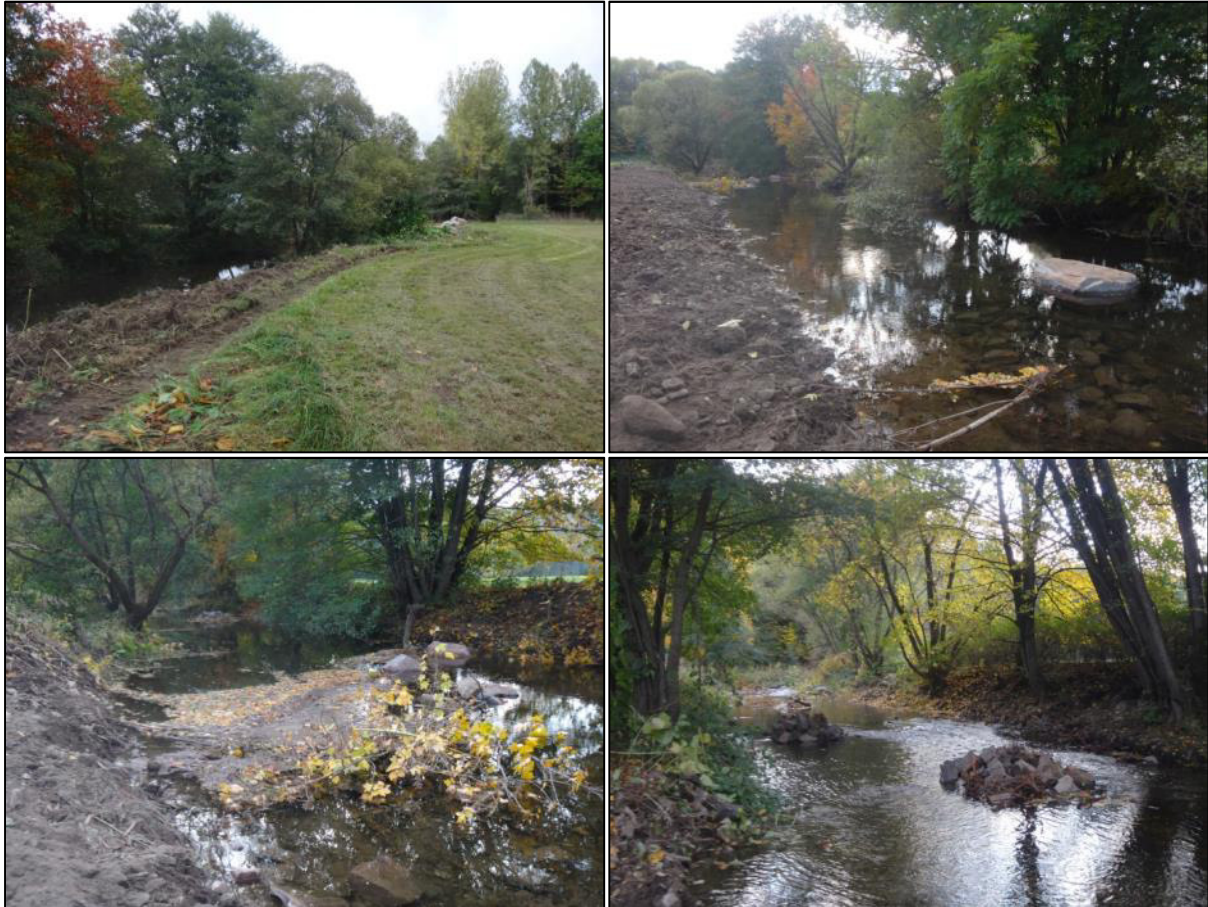
Abb. 14: Strukturierungsmaßnahmen Amalienhütte. Oben links: Zufahrt ausschließlich von rechter Uferseite mit ehemaligem Bärenklaubewuchs. Oben rechts: Rechte Uferseite nach Rückbau der Ufersicherung, Abflachung der Ufer und Einbau großer Steine. Unten links: Eingebauter Baum mit Ankersteinen. Unten rechts: Aufgehäufte Wasserbausteine als Strömunglenker.
