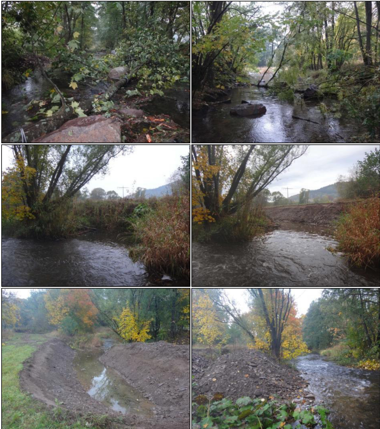
Abb. 15: Strukturierungsmaßnahmen Wehr Bohne. Oben links und rechts: Strukturierung mit Steinen und eingebauten Bäumen mit Ankersteinen unterhalb des Wehrs. Mitte links und rechts: Winterquartier oberhalb Furth vor und nach Erweiterung. Unten links: Übersicht Winterquartier. Unten rechts: Kiesiger Aushub von Winterquartier wurde entlang der Lahn unter Schonung der dort ansässigen Pestwurzfluren als Geschiebedepot gelagert.
