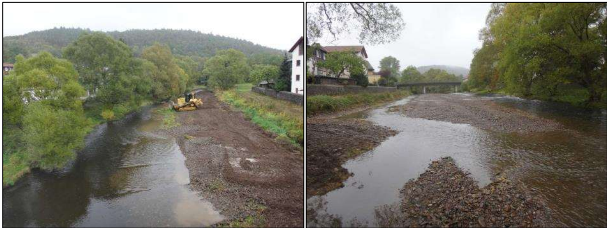
Abb. 6.5: Strukturverbessernde Maßnahmen - Buchenau. Links: Schälung der Kiesbank. Rechts: wiederhergestelltes Furkationsgerinne.
