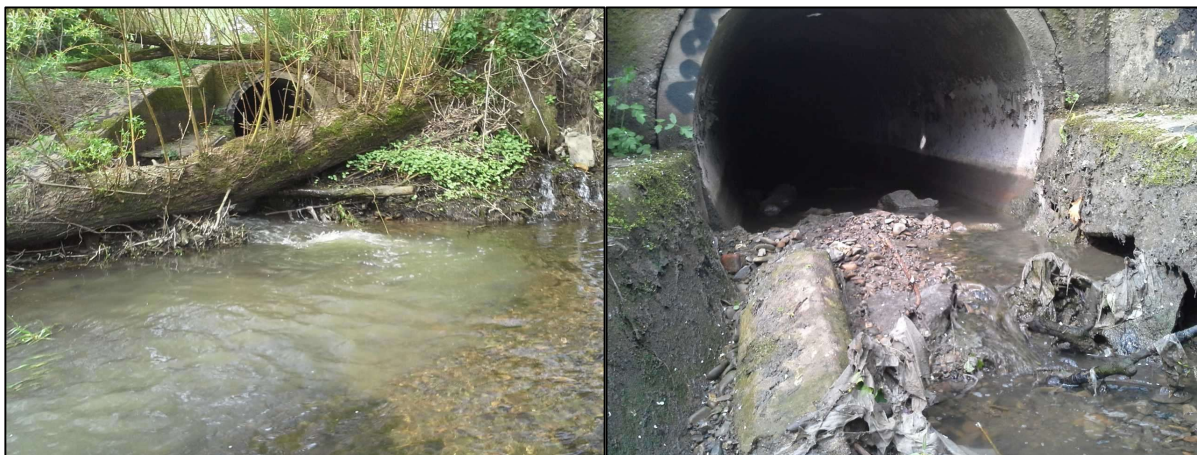
Abb. 5.15: Abwassereinleitung am 23.04.2018 innerhalb der Probestrecke Wilhelmshütte, ca. 30 m oberhalb der Probestellen. Links: deutlich sichtbare Trübungsfahne (erstreckte sich über > 100 m im Gewässer). Rechts: an der Höhe der ehemaligen Wasserkante im Rohr ist erkennbar, dass größere Flüssigkeitsmengen durchgeleitet wurden. Im Vordergrund aus dem Abwasser stammender Unrat (Toilettenpapier etc.).
