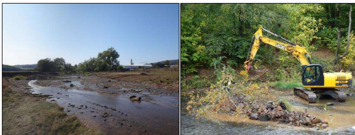
Abb. 6.6: Strukturverbessernde Maßnahmen – Sterzhausen und Cölber Wald. Links: Flach überströmter Bereich mit Störsteinen zur Initiierung einer Kiesbank (Sterzhausen). Rechts: Einbau eines Baums als Strömunglenker (Cölber Wald).
