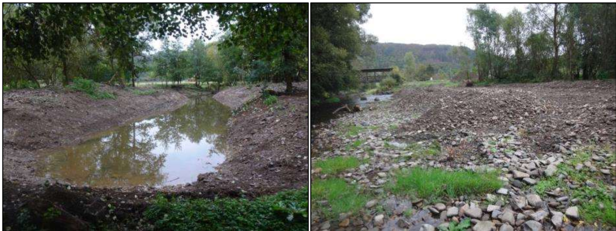
Abb. 6.3: Strukturverbessernde Maßnahmen - Wallau. Links: neu angelegtes Nebengewässer auf Kiesbank (potentielles Winterquartier). Rechts: Kiesdepot.
