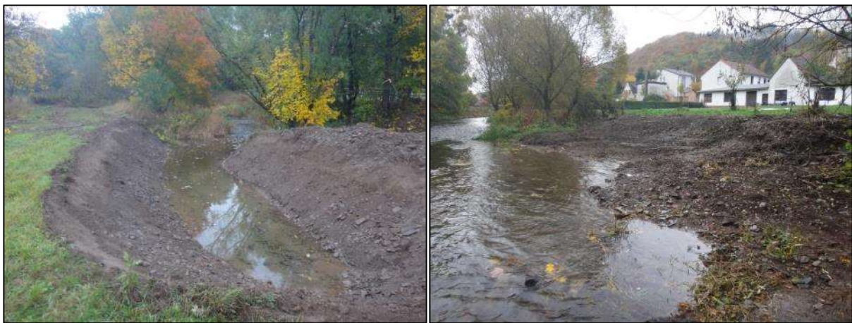
Abb. 6.2: Strukturverbessernde Maßnahmen – Wehr Bohne und Biedenkopf-Sachsenhausen. Links: Erweiterung Winterquartier (Wehr Bohne). Rechts: neu angelegte Buchten im abgeflachten Ufer (Biedenkopf-Sachsenhausen).
